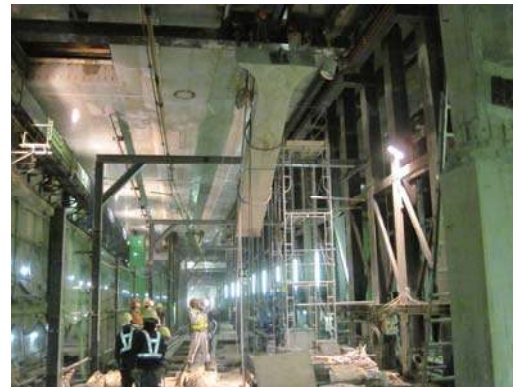
写真-2 既設構造物撤去状況（ロート部）
