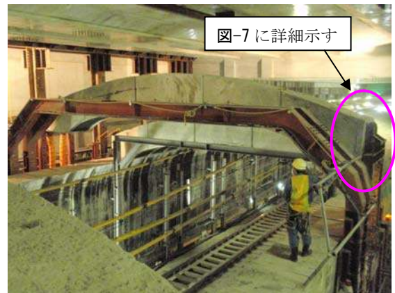
写真-1 アーチ部の撤去状況
