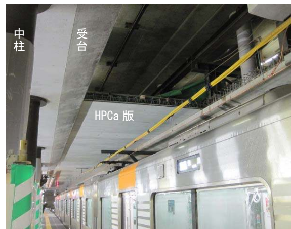
写真-3 HPCa版の施工状況
