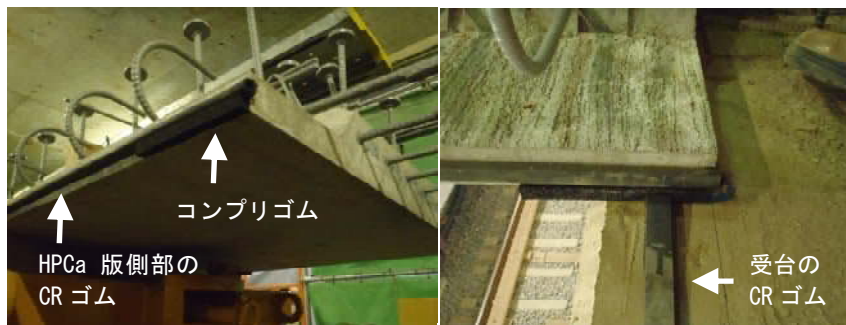
写真-4 漏水防止ゴムの設置状況
